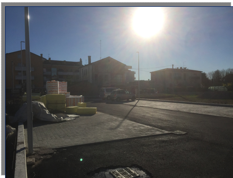
Foto 02 vista dall'angolo nord-ovest del nuovo parcheggio interno al P.E.E.P.
