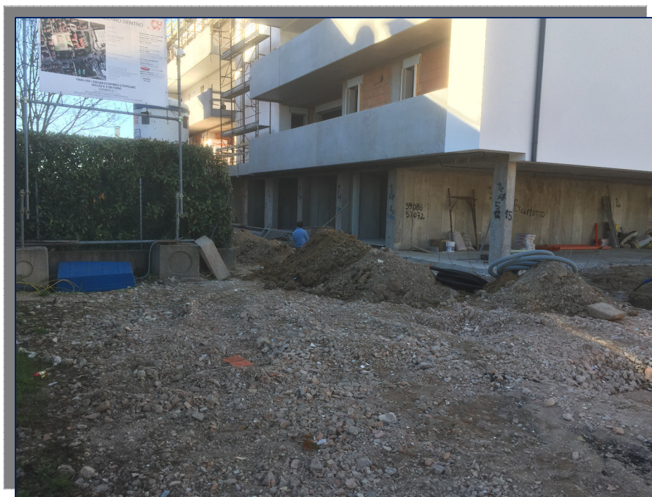
Foto 06 vista dell'accesso all'ambito fondiario E02 (oggetto di modifica)
